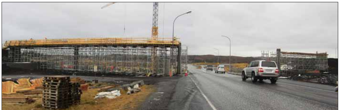
Göngubrú yfir Breiðholtsbraut á milli Seláss og Norðlingaholts í byggingu 22.10.2014.
